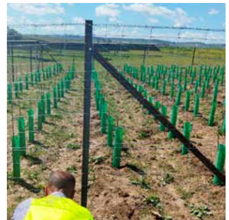
Instalación de Vallado
