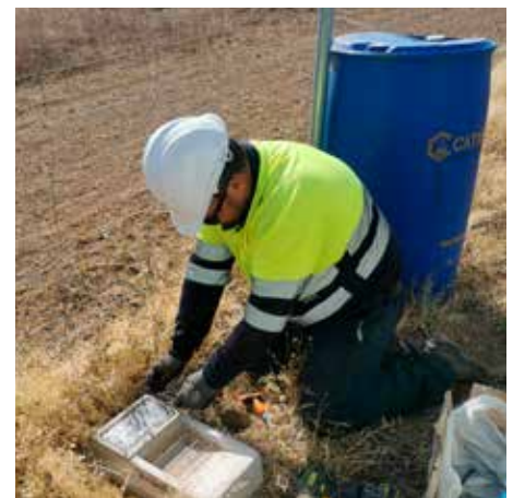
Instalación de bebederos
