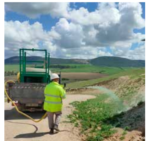
Hidrosiembra de taludes
