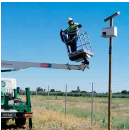
Instalación de cajas nido / postes de oteo
